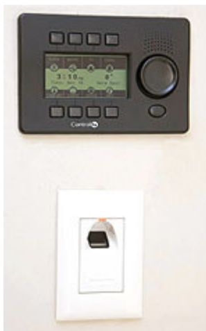
Controle de ar-condicionado que pode ser usado independentemente ou por meio do sistema central, teclado (preto) de controle de acesso e sistema de biometria (branco): também interligados à central
