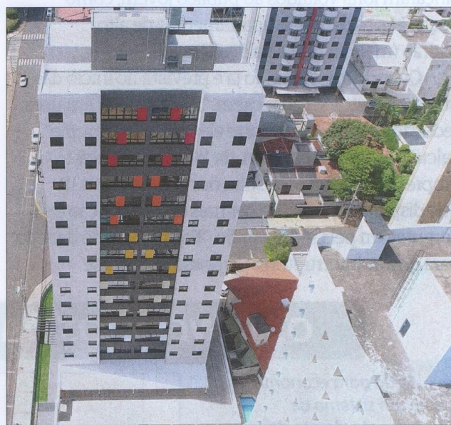
Edifício novo em SP: automação gera economia de 25% nos custos da rede elétrica.
